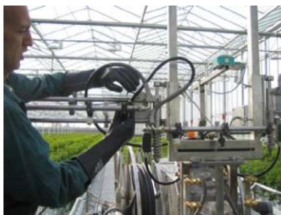
Фиг. 3.18 Подсоединение шланга подачи рабочей жидкости
