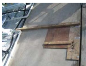
Фиг. А3 Шаблон для сверления углублений под стоп- метки
