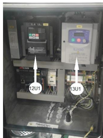
Фиг. 8.1b Регуляторы частоты (р/ч) на опрыскивающей установке: 12U1= р/ч двигателя привода (перемещения) 13U1= р/ч мотора вентилятора
