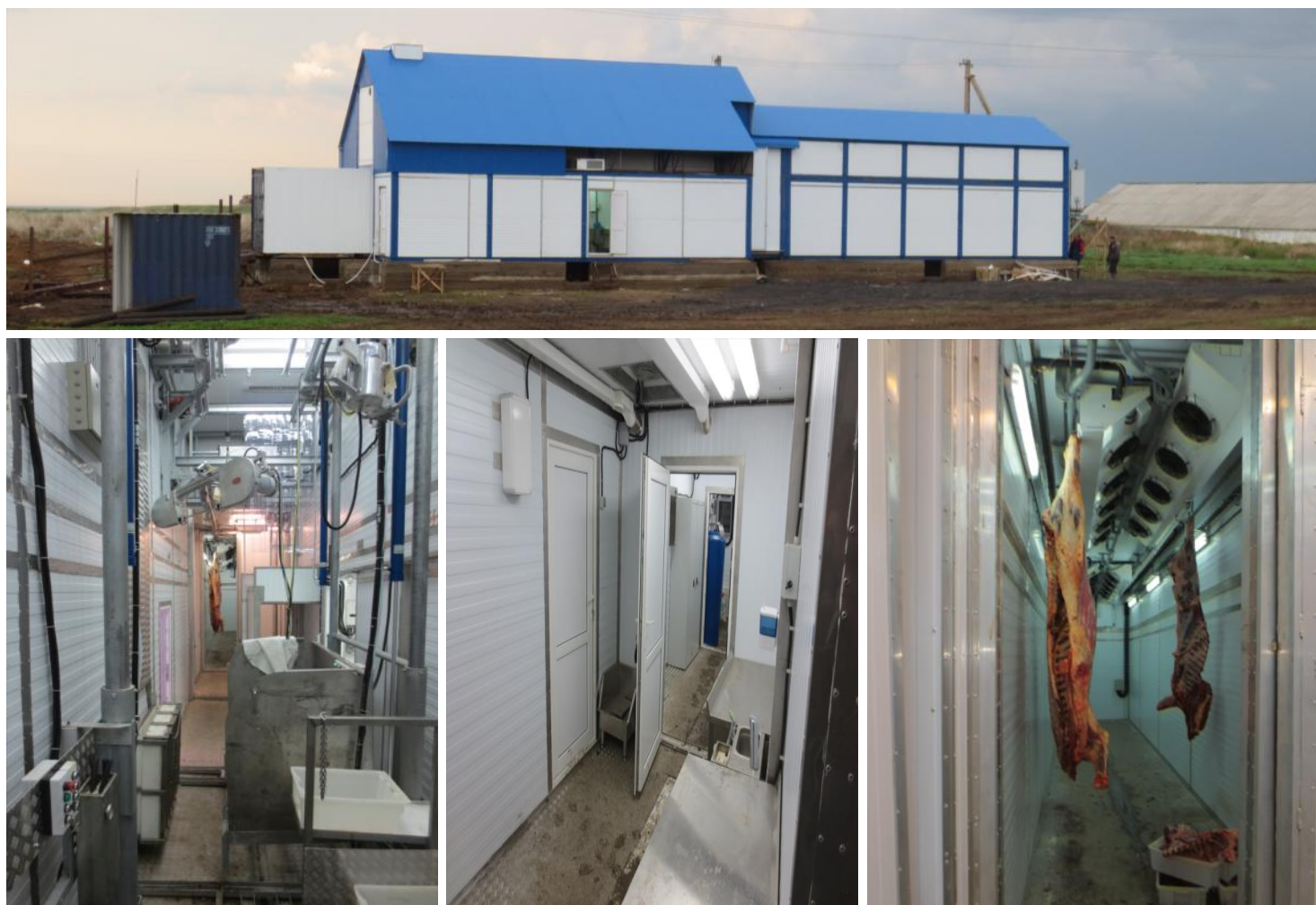
Комплекс убоя с холод. и морозильной камерами, каб. ветврача. Казахстан.
